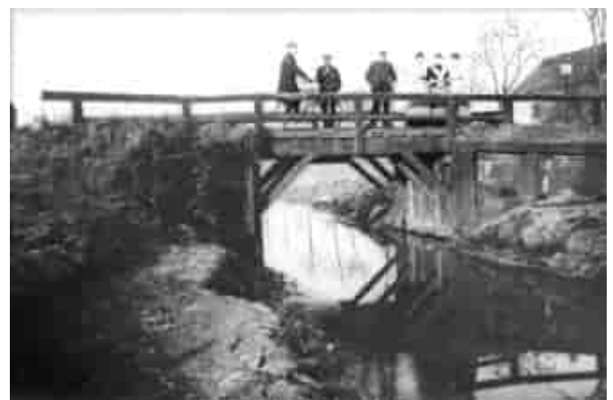
oben: Die hölzerne Kanalbrücke am Bresserhof.
