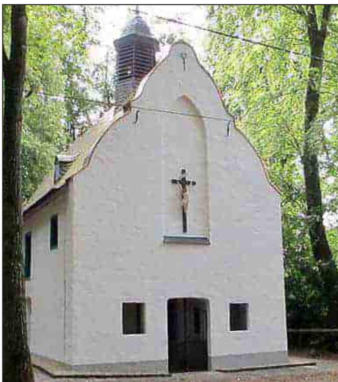
Die Irmgardiskapelle nach der Renovierung
