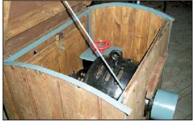
Alles wieder ein- und angebaut
