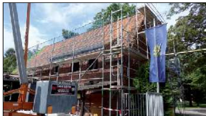
Die Baumaßnahme beginnt
