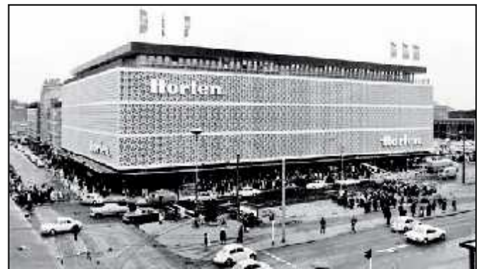
Ein Horten-Kaufhaus mit der typischen Fassadenverkleidung
