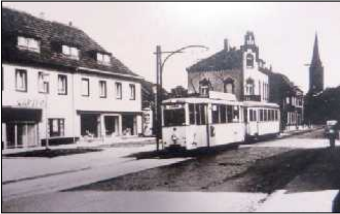
Die Bahn im Jahr 1955 auf der Hochstraße
