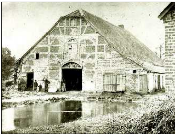
Der alte Dommershof vor dem Abbruch
