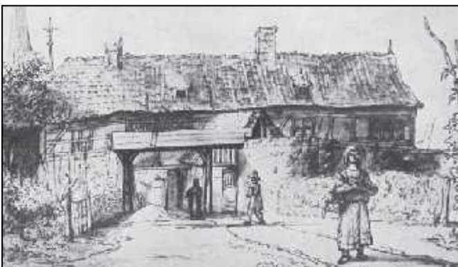
Toranlage in Anrath
